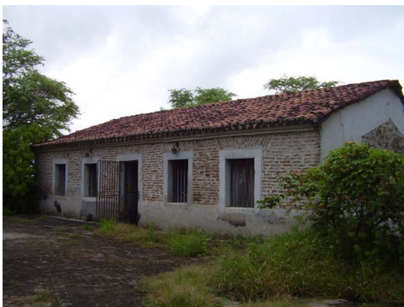
Figura 34: Casa grande da Fazenda Caiçara Fonte: Fundarpe
