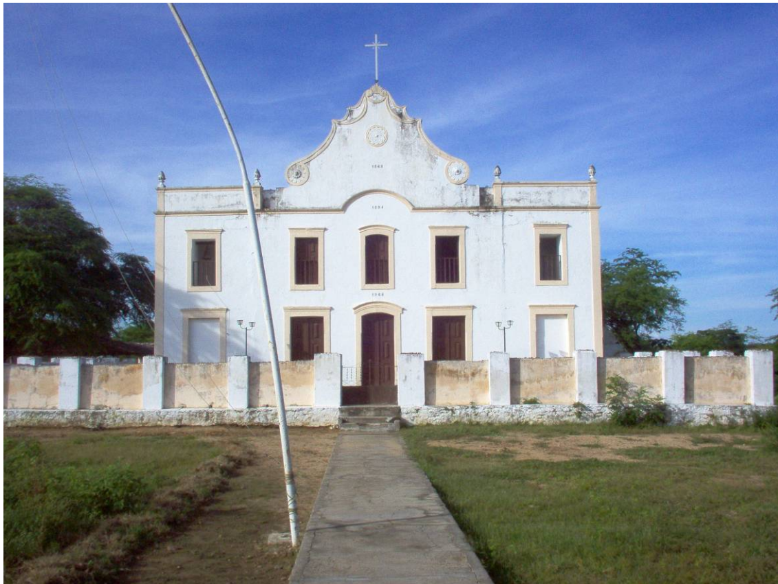
Figura 4: Igreja de São João Batista, construída pelo Barão do Exu, em 1868. Fonte: Fundarpe
