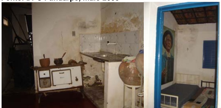
Figuras 69 e 70: Interior da edificação Fonte: DPC Fundarpe, maio 2008
