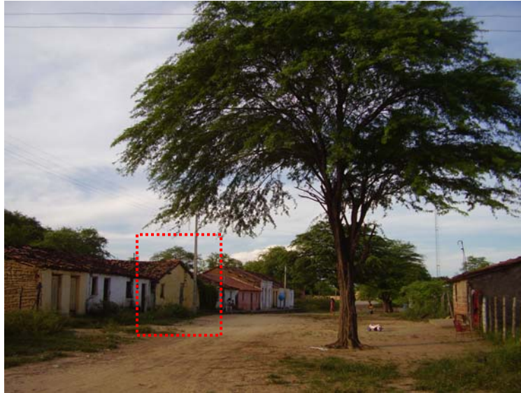
Figura 44: Vista do arruado onde se encontra a Casa de Januário Fonte: DPC Fundarpe, maio 2008
