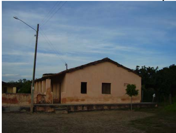
Figura 50: Vista da 2ª. Casa de Januário - fachada frontal; sem escala Fonte: DPC FUNDARPE
