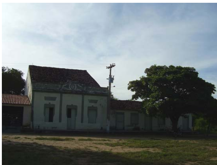
Figura 36: Vista da Casa Grande com a senzala ao lado Fonte: DPC Fundarpe, maio 2008
