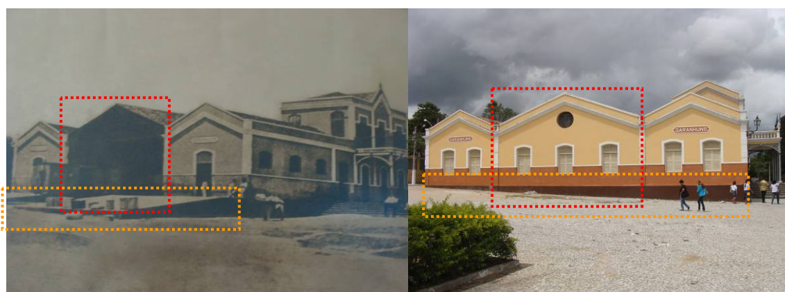
Figuras 19 e 20: a. Foto antiga da Estação, fachada lateral esquerda e suas plataformas e b. Situação atual, fachada lateral esquerda e a subtração das plataformas, bem como o entaipamento da porção central para abrigar o novo uso – Teatro. Abertura de janelas no local das antigas portas; Fonte: a. Fotografia do Quadro da Secretaria de Cultura. DPC Fundarpe, março 2009
