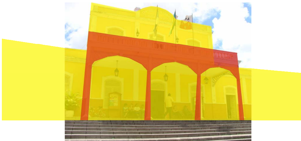
Figura 16: Volumetria Frontal com pequenas alterações, considerada preservada; Fonte: Fotografia da edificação, DPC – Fundarpe; elaborado por Daniella Esposito
