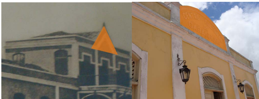
Figuras 21 e 22: Comparativo entre a fachada frontal antiga e a atual da edificação; destaque para a transformação na forma do frontão; Fonte: DPC- Fundarpe, março 2009; elaborado por Daniella Esposito
