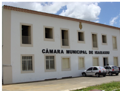
Foto 1. Fachada principal da antiga casa de Câmara e Cadeia de Igarassu.
