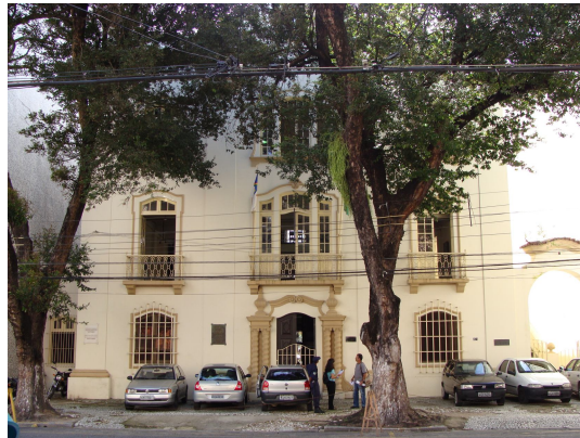
Foto 3. Fachada principal da antiga casa de Câmara e Cadeia de Recife.
